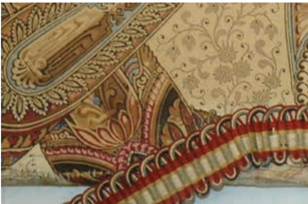
Onder de sierband zijn de oorspronkelijke kleuren van deze wandbespanning zichtbaar. ©Joke Vandermeersch
